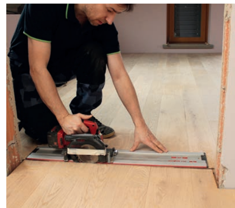
Prořeznutí dilatace v podlaze
