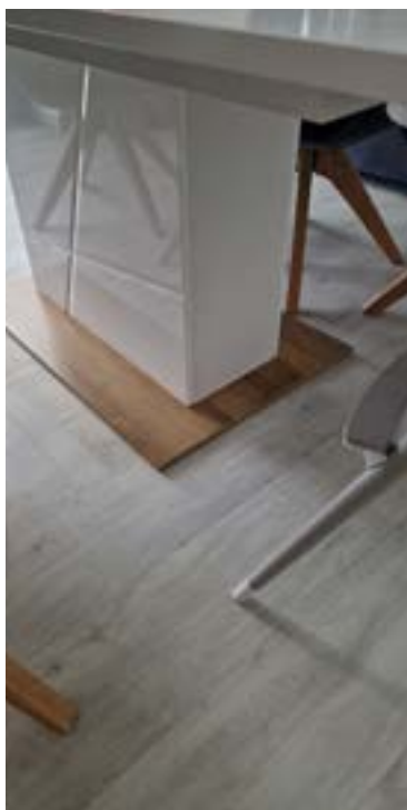
● Nevhodný nábytek na podlahovém topení
