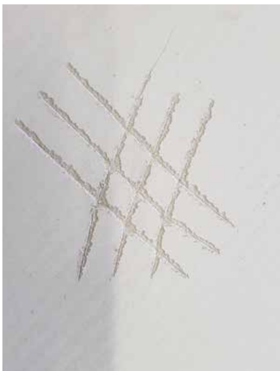
❶ Mřížková zkouška běžná kvalitní stěrka po 24 hodinách
